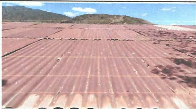
Foto 2: Vista el techo media agua (es de dos aguas) de Oriente a Poniente
