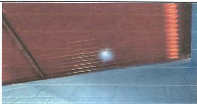
Foto 6: Vista del techo de la parte interna de Segundo Grado Seccion A
