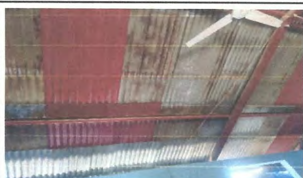
Foto 4: Vista del techo de la parte interna del 4o. Grado, Sección B
