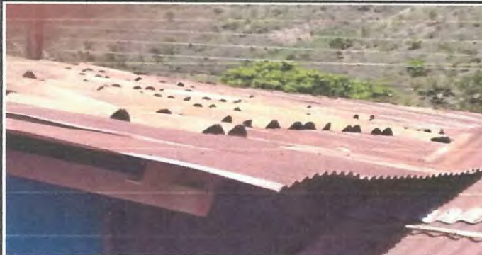
Foto 3: Vista del techo de los grados 2o A, 4o.B y Primero B. de Oriente a Poniente.
