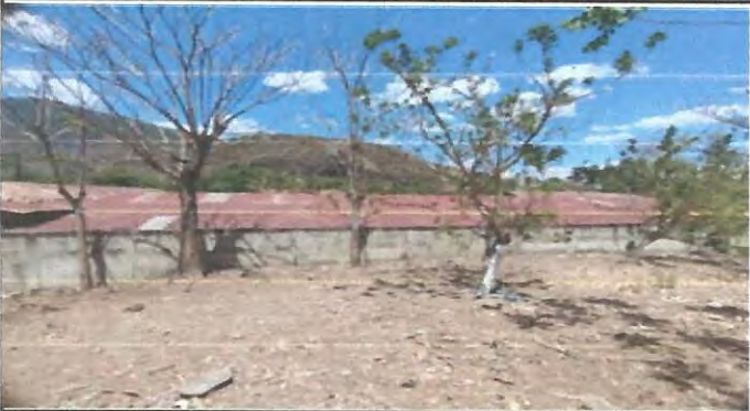
Foto1: Vista de la parte Oriente a Poniente del edificio escolar
